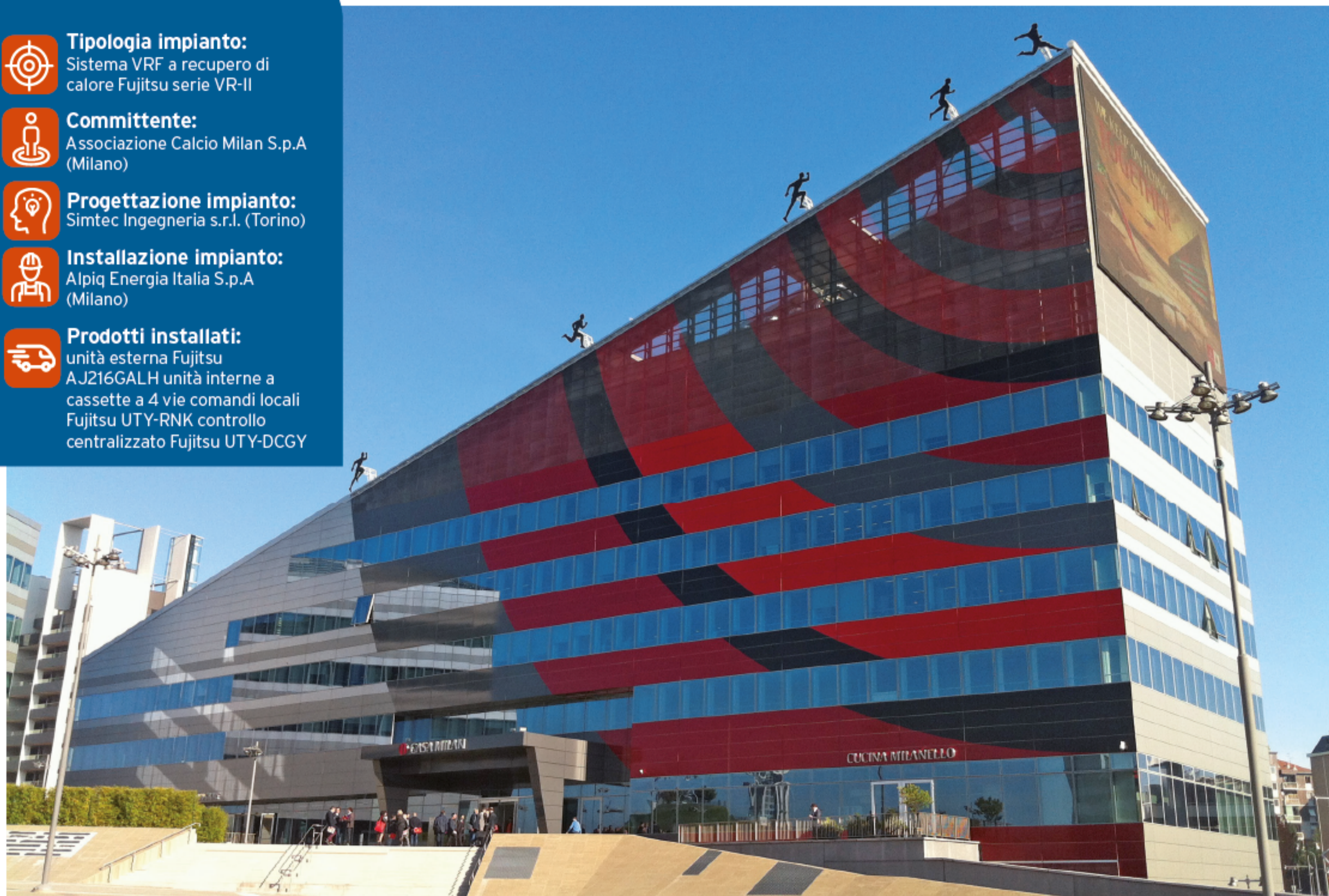
"CASA MILAN", il nuovissimo headquarter del Milan è un edificio di 9.000 m 2 realizzato in Via Aldo Rossi a Milano.
