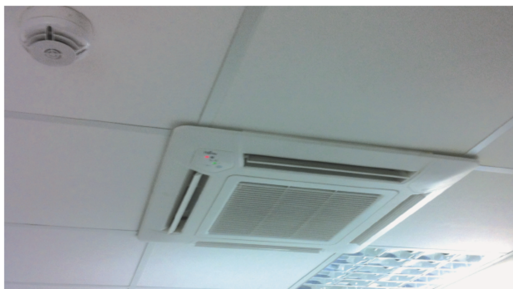
LA TECNOLOGIA del sistema VR-II consente di raggiungere la massima flessibilità nella progettazione delle tubazioni consentendo di superare dislivelli fino a 50 m e lunghezze effettive delle tubazioni fino a 165 m.
