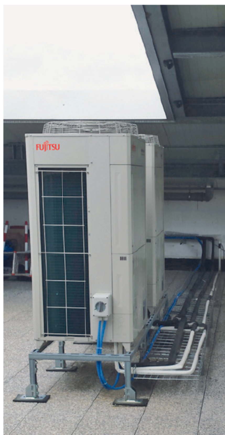
RECUPERO DI CALORE. Il sistema a Fujitsu utilizza la tecnologia a 3 tubi per avere inferiori perdite di pressione e una minore temperatura di condensazione.
